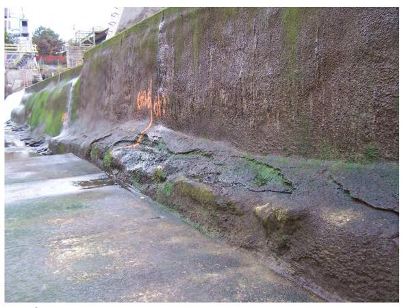
78. Sta 6+25. Eroded shotcrete.
